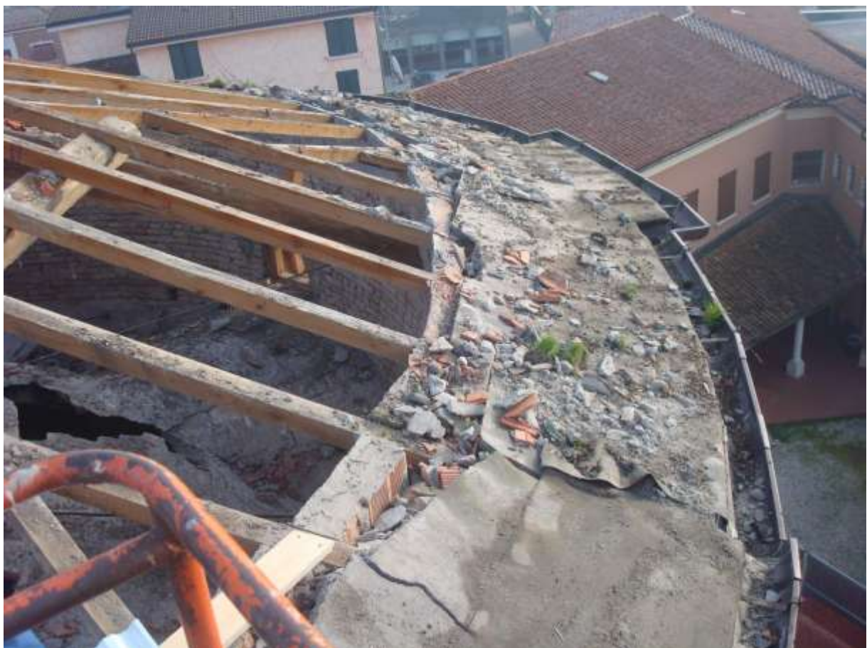
Estradosso volte e copertura 8
